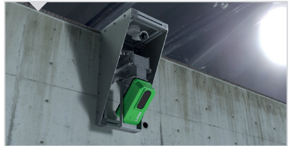
Die Laserscanner können flexibel an der Decke, an Wänden oder an individuellen Montagekonstruktionen in der Nähe des Messortes angebracht werden.
